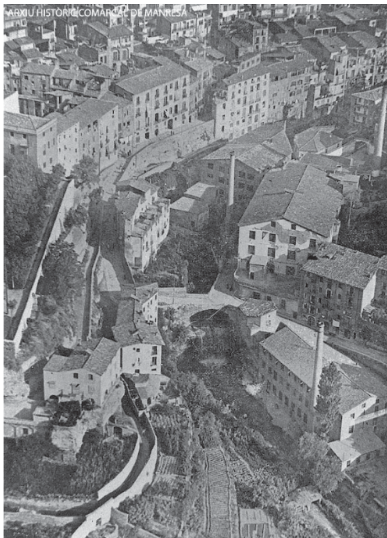
Fotografia del carrer de Sant Bartomeu 1910-20 (Font: Arxiu Històric Comarcal del Bages)
