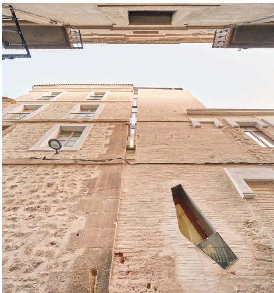
Rehabilitació de la façana sud amb el volum del nucli del muntacàrregues
