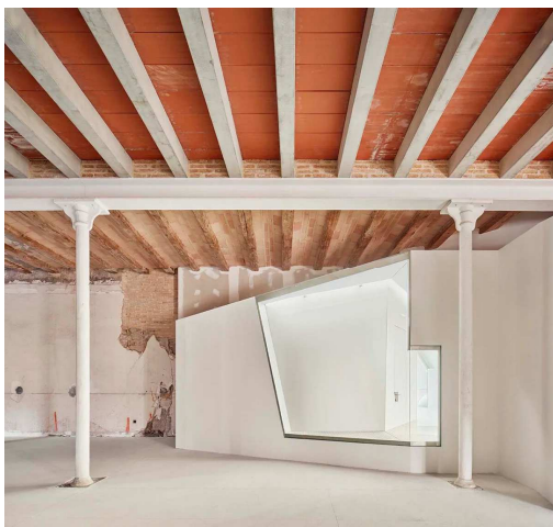
Rehabilitació dels sostres de les ales oest i nord
