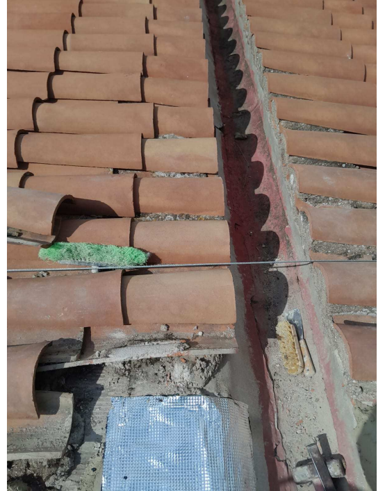
Estat actual de les canals de les cobertes
