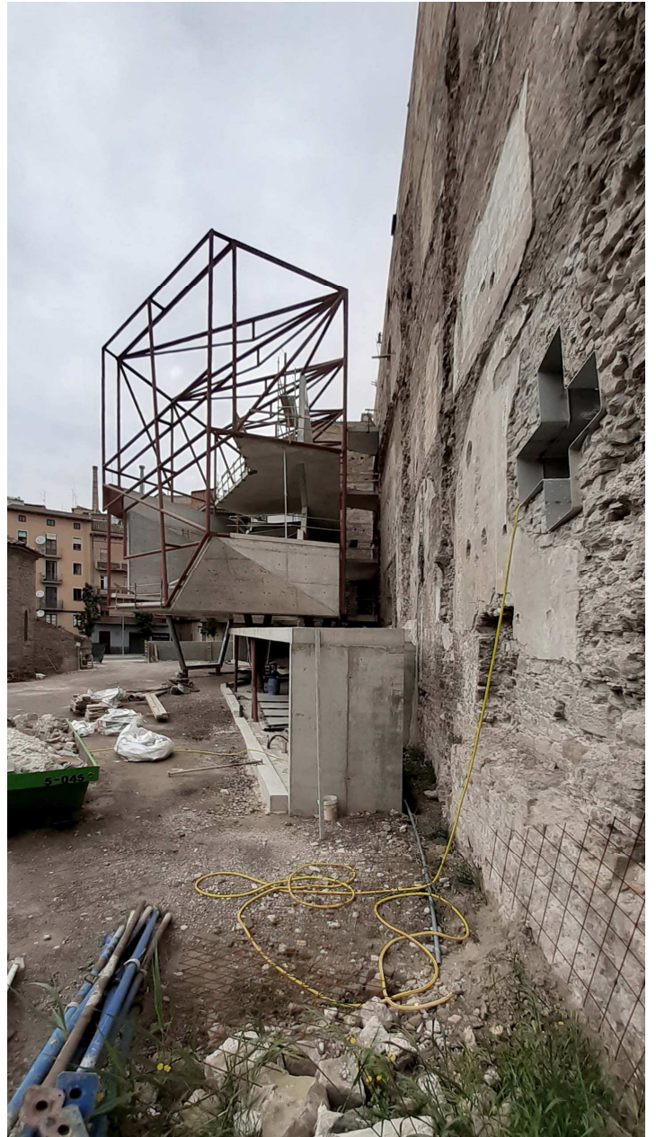
Estat de les obres dels nous volums d'accés el maig del 2020
