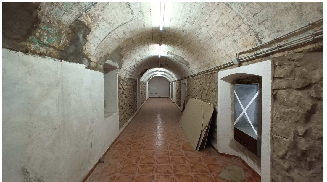
Estat actual de l'ala nord de la planta entresòl
