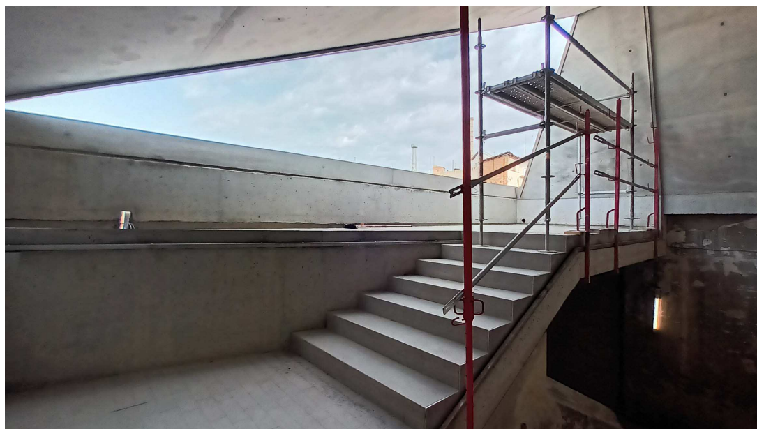
Estat de les obres del remat superior de l'escala històrica de l'edifici
