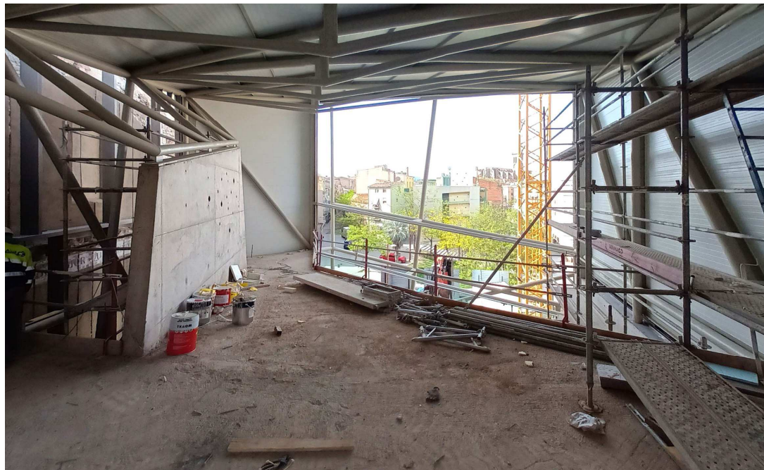
Estat de les obres de la planta segona del nou volum d'accessos al museu
