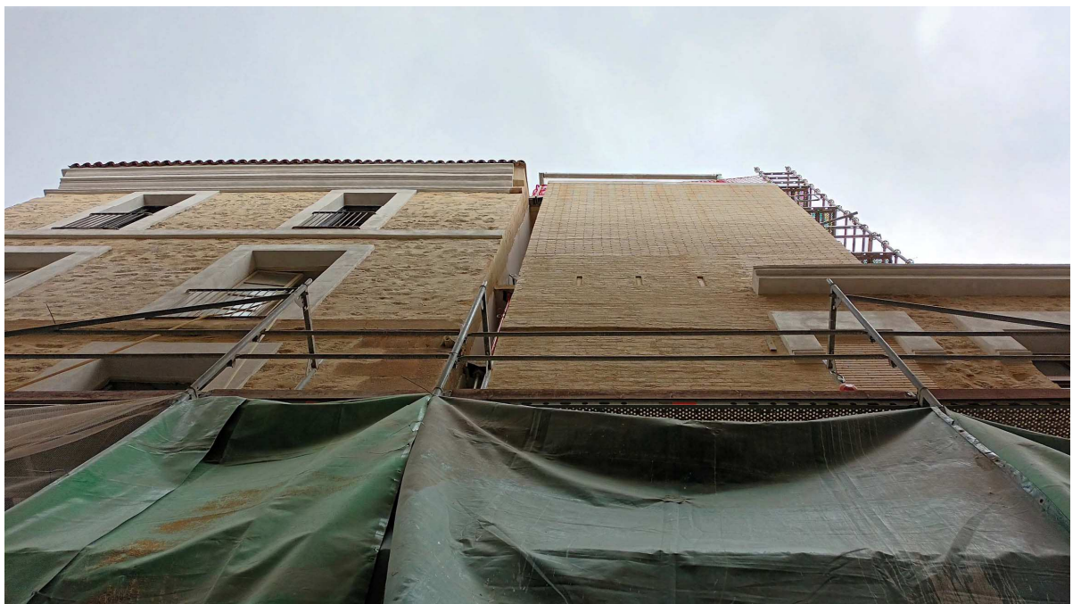
Estat de les obres d'intervenció a la façana de l'ala sud de l'edifici
