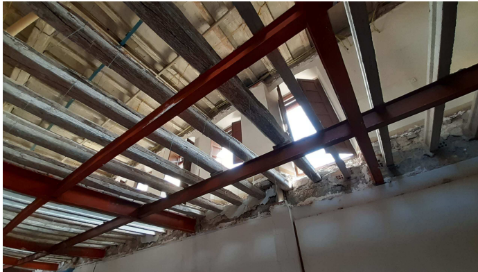
Rehabilitació dels sostres de l'ala oest (octubre del 2020)
