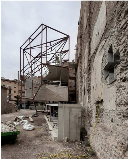
Nous volums d'accés a l'edifici (maig del 2020)
