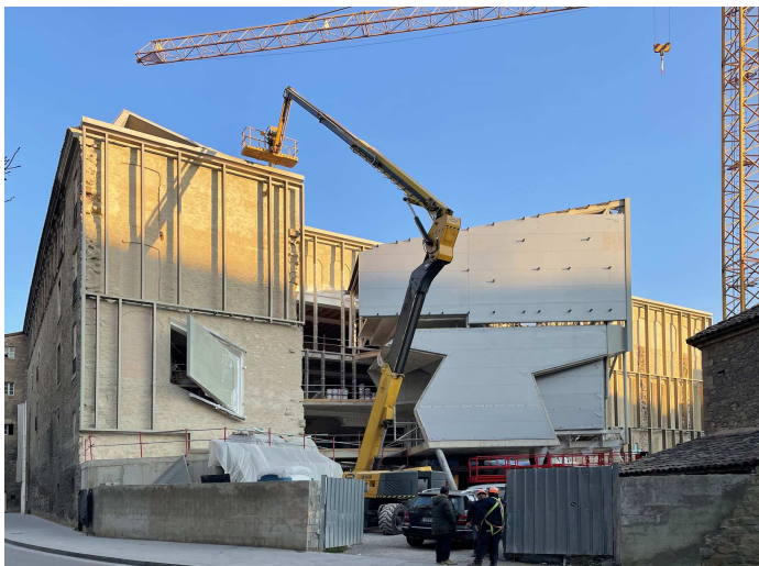
Nous accessos a l'edifici (gener del 2022)
