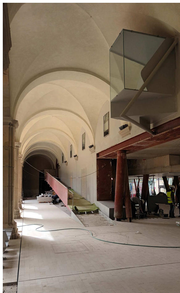
Estat de les obres al claustre. Ala nord i ala oest
