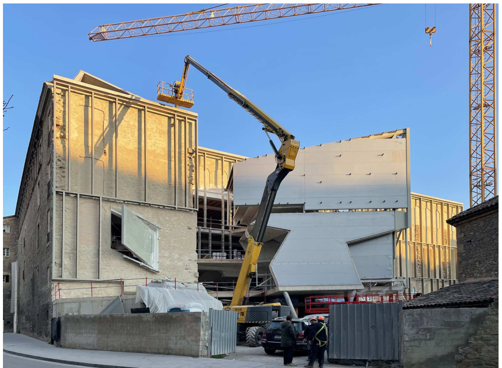
Estat de les obres dels nous volums d'accés el gener del 2022
