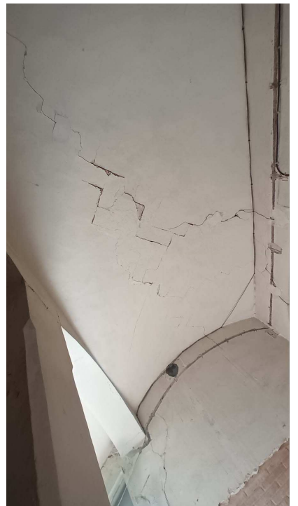
Estat actual de les voltes dels replans de l'escala històrica
