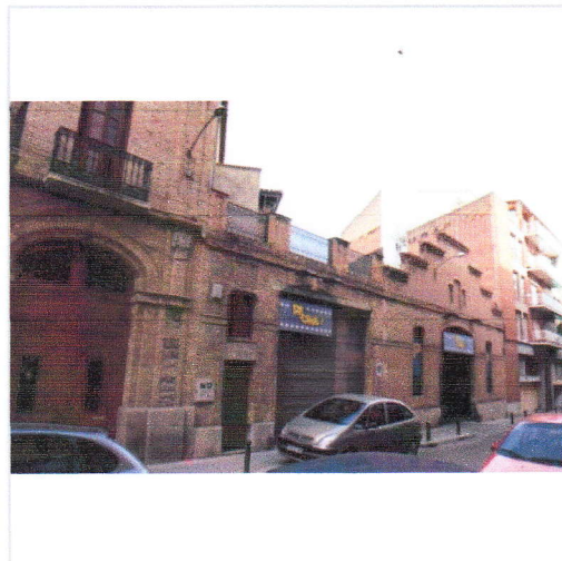
Façana de la nau industrial
