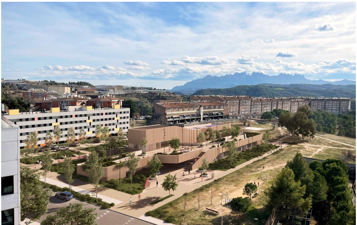
Imatge de la Fase 1 del projecte de l'Edifici del Coneixement. Font PMMT.
