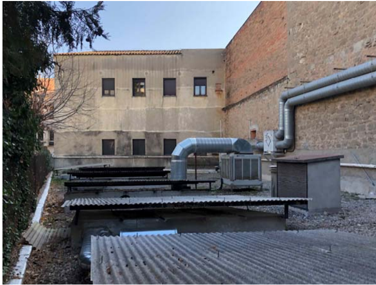
Vista de la façana posterior del cos de l'edifici Morenetes
