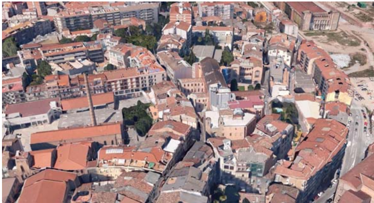
Vista aèria Hospital de Sant Andreu des del sud
