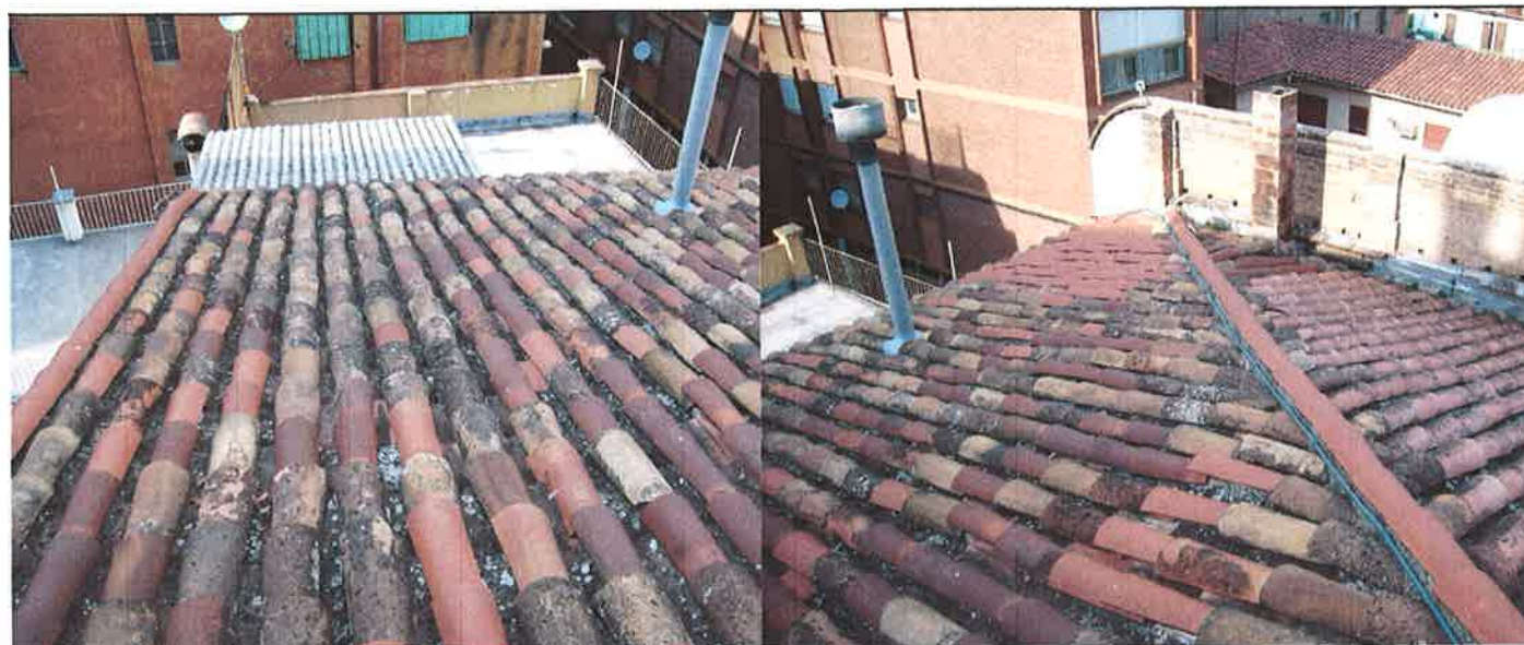
Cobertes - Cantonada C. Circumval·lació - Ctra. de Vic Núm. 81 (Edifici Catalogat)
