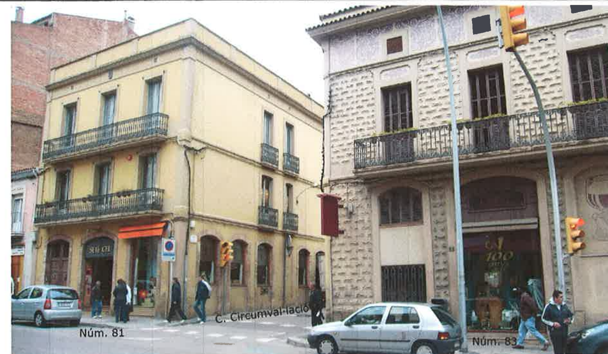
Ctra. de Vic Núm. 81-Núm. 83 Cant. C. Circumval·lació (Edificis Catalogats)
