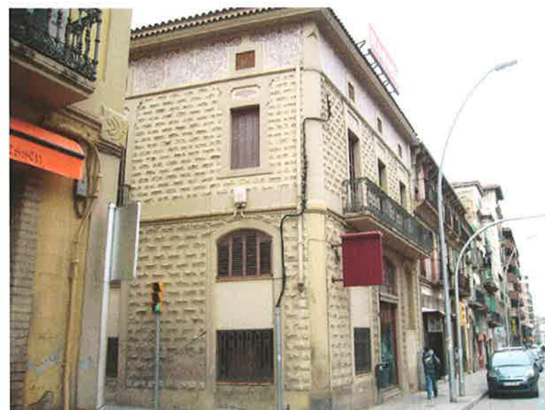
Cantonada C. Circumval·lació - Ctra. de Vic Núm. 83 (Edifici Catalogat)
