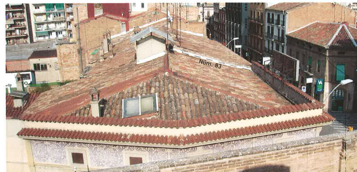
Cobertes - Cantonada C. Circumval·lació - Ctra. de Vic Núm. 83 (Edifici Catalogat)
