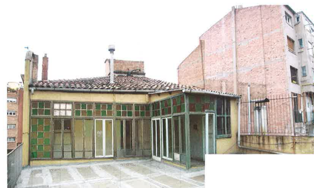
C. Circumval·lació Núm. 120 (coberta) / Núm. 81 de la ctra. de Vic (Edifici Catalogat)
