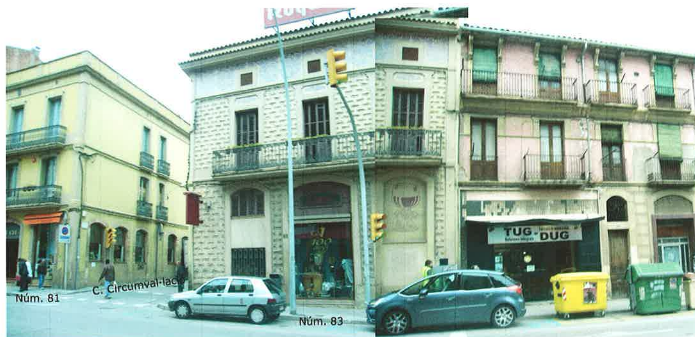
Ctra. de Vic Núm. 81-Núm. 83 Cant. C. Circumval·lació (Edificis Catalogats)
