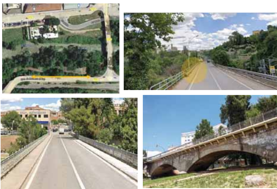
Figura 82. Estat actual dels accessos i Pont de Sant Francesc
