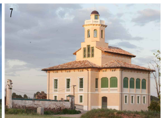
Façana sud-oest. Tanca-portal sud
