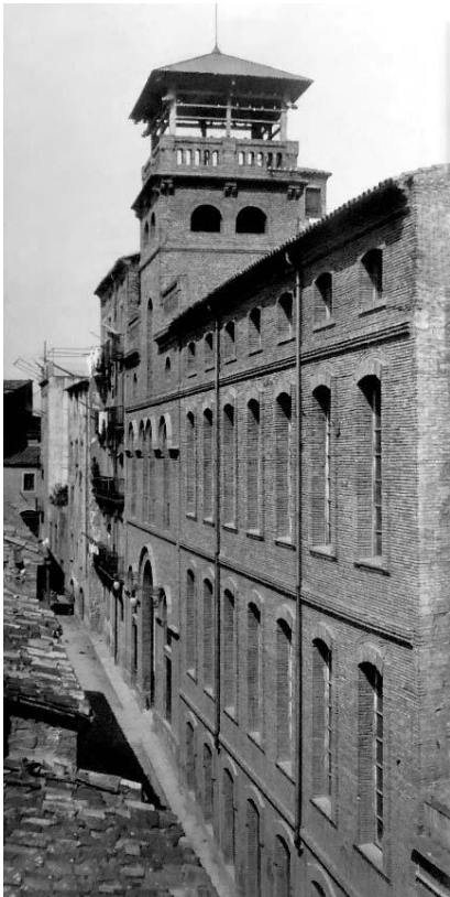
Imatge de la Façana del C. Llussà on s'aprecia el volum original donant a façana.
