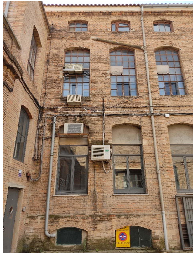
A la façana interior veiem arcs rebaixats de maó de pla a les obertures.
