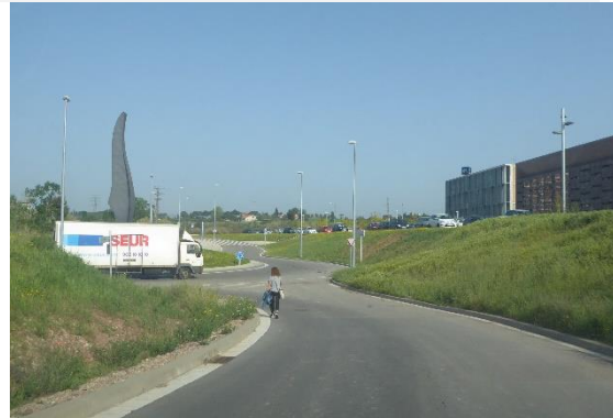
Vianant a la calçada per la urbanització provisional del Camí del Sant Crist del Guix. Caldrà resoldre aquesta connexió a peu en la urbanització definitiva
