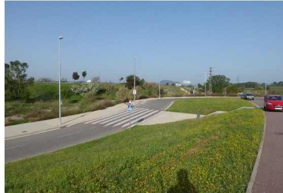
Pas de vianants elevat al carrer Albert Einstein i accés a l'àmbit superior
