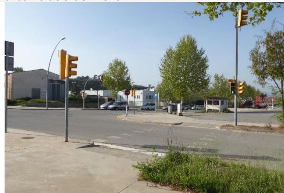
Pas de vianants adaptat i semaforitzat per creuar el carrer de Sallent a la cruïlla amb el carrer Castelladral
