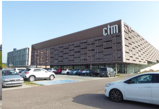
Aparcament davant de l'edifici CTM amb 1 plaça reservada per a PMR
