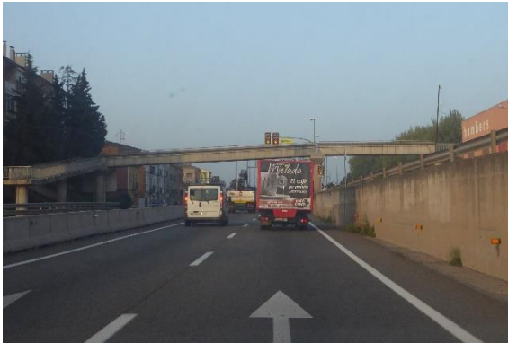
Passarel·la de vianants per creuar la carretera C-16C a l'alçada dels bombers
