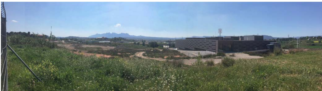
Foto 4. Vista de les edificacions existents des de dalt del camí de la sèquia
