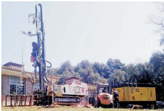
Perforació del camp de captació
