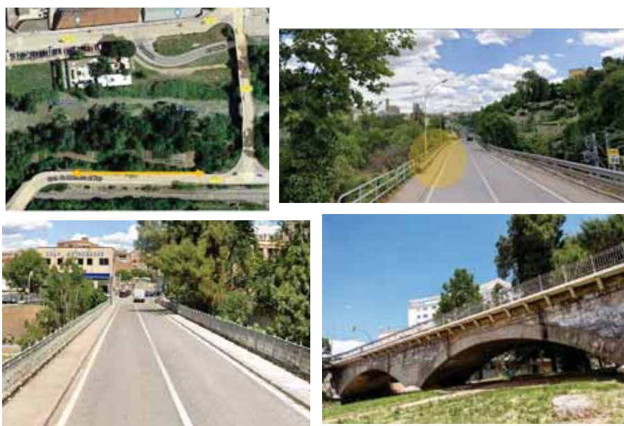
Figura 86. Estat actual dels accessos i Pont de Sant Francesc
