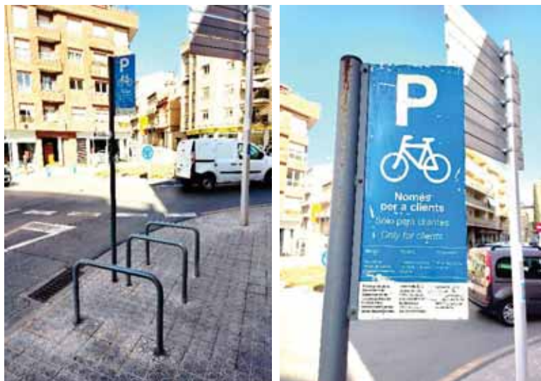
Figura 108. Aparca-bicis a l'exterior de l'Estació FGC Manresa Baixador
