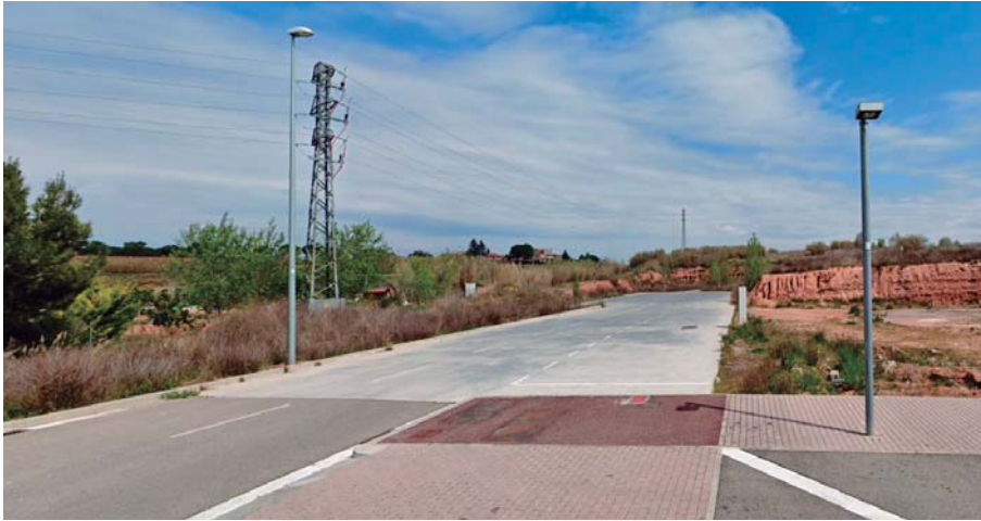
Paviment dins d'àmbit al carrer d'Einstein format per una llosa de formigó
