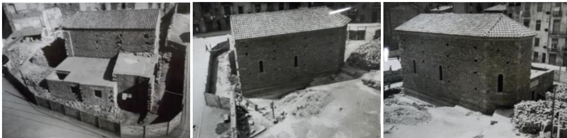
Obres de construcció de la Capella del Rapte (vers 1954). Font: Vivències. Les Congregacions Marianes a Manresa 1939-1969. Manresa 1973. Pag. 65 i 66. Estudi històric, arquitectònic i constructiu de l'àmbit oest de l'antic col·legi de Sant Ignasi a Manresa. Jordi Morros Cardona
