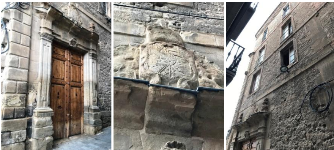
Ala Oest - Imatges de la façana al carrer Viladordis. Vista de la portalada de l'antic col·legi Sant Ignasi, detall de l'escut i vista a tota alçada. Març 2018
