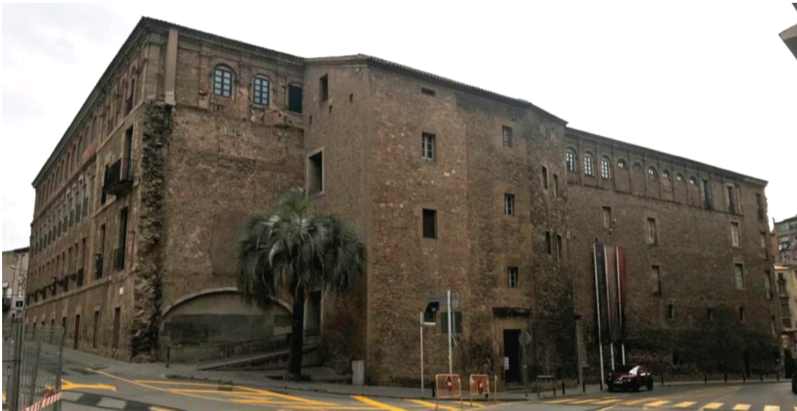
Ala Nord i ala Est - Imatges de les façanes a la Via Sant Ignasi i al carrer Vidal i Barraquer. Abril 2018
