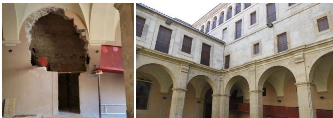
Imatges de les intervencions.
