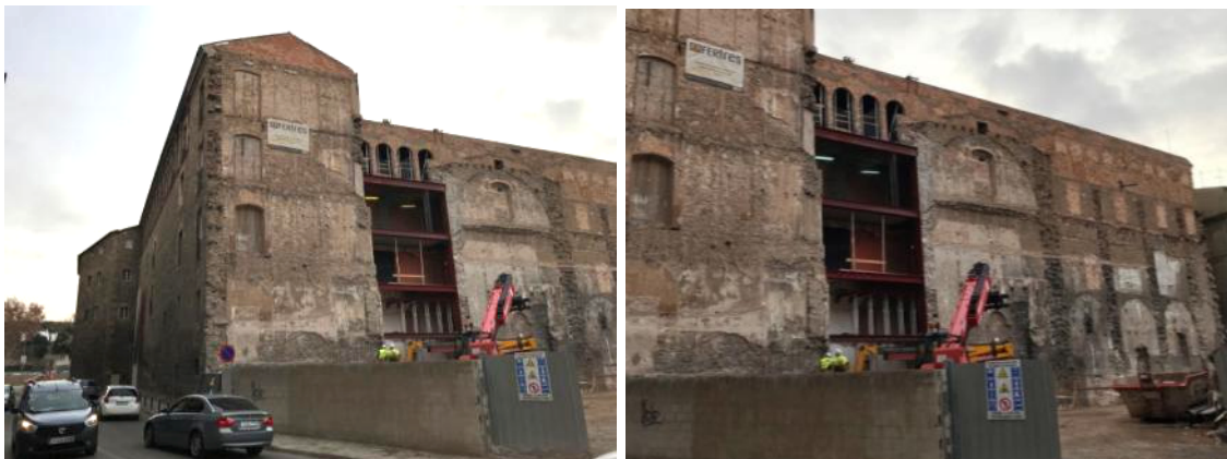
Ala Nord i ala Oest - Imatges de les façanes a la Via Sant Ignasi i al solar sorgit dels enderrocs. Desembre 2017
