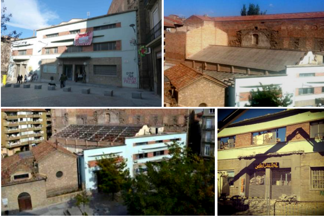
Imatges del conjunt. Octubre 2015. ManresaInfo. Fotos: Pere Fontanals / Imatge enderroc façana. Foto: Jordi Bonvehí
