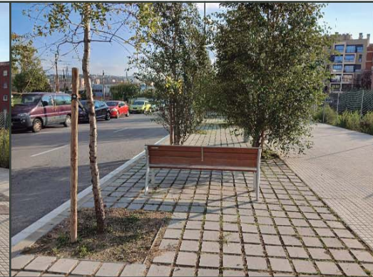
Imatge nº 8, Camí vell de Santpedor, Detall vorera estada PAU 009, Paviment de junt obert d'ample 3,5m amb escocell singular (Fraxinus), doble (2 x populus) i mobiliari.
