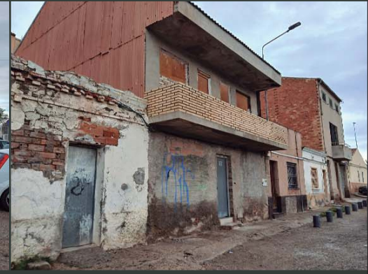
Imatge nº 8. Habitatges preexistents a enderrocar per adaptar-se a les noves alineacions definides al POUIM per al PAU 073.
