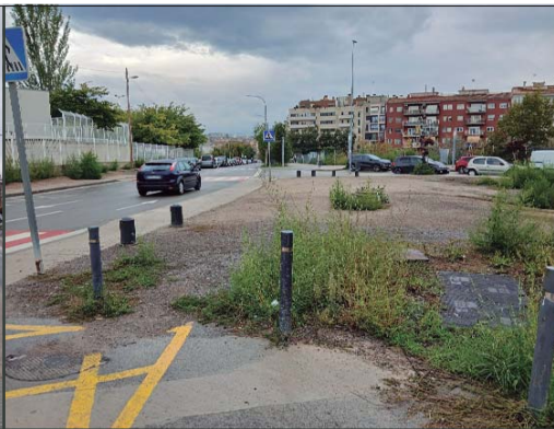
Imatge nº 2. Camí vell de Santpedor, vorera àmbit. Tram sense urbanitzar però amb instal·lacions de serveis existents a considerar.
