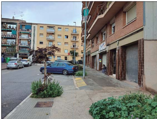
Imatge nº 1, Enric Granados, Vista retranquej vorera est al punt on finalitza l'edificació, En primer pla vista de l'Abízia Julibrissim amb problemes de creixement.
