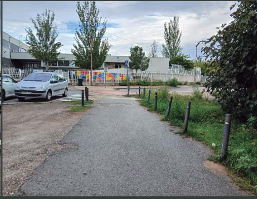
Imatge nº 6. Camí vell de Santpedor. Camí asfaltat que dona accés als habitatges preexistents del sector I connecta amb el Ptge. de Santpedor.
