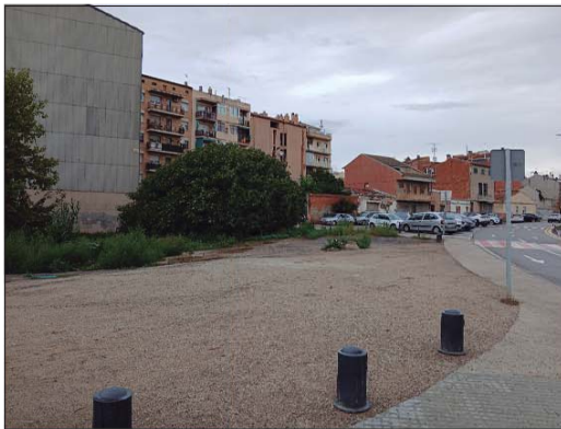
Imatge nº 1. C/El camí vell de Santpedor - Enric Granados. Vorrera de formigó provisional amb espai sense urbanitzar i zona de vegetació entonsada.
