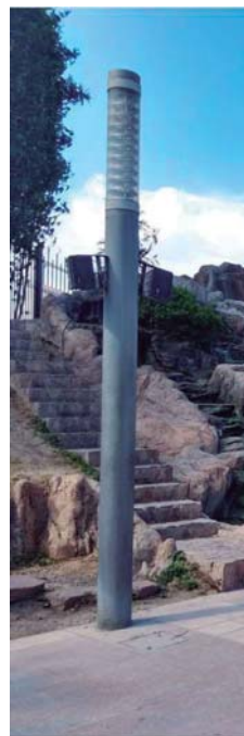
Conjunt columna i lluminària tipus Kuma d'acer galvanitzat de Simon Lighting o equivalent.
