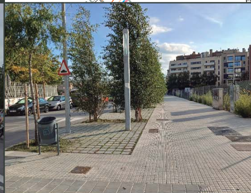
Imatge nº 7, Camí vell de Santpedor, Vorera tram PAU 009. Urbanització de referència amb vorera de pas (panot) i vorera d'estada (paviment junt obert), Llum Kuma + Bàcul Tau S LED
