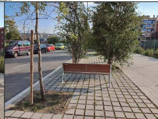
Imatge nº 8, Camí vell de Santpedor, Detall vorera estada PAU 009. Paviment de junt obert d'amplà 3,5m amb escocell singular (Fraxinus), doble (2 x populus) i mobllar.
