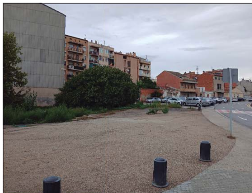
Imatge nº 1. Cruïlla camí vell de Santpedor - Enric Granados. Vorera de formigó provisional amb espai sense urbanitzar i zona de vegetació enfonsada.
