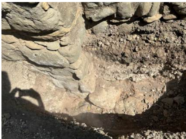
Imatges 240617-03 i 07. Exemples de cales de fonamentació a la cantonada sud-est de la torre (C8), i a l'extrem sud del contrafort de la façana est (C9), respectivament. En ambdós casos el recolzament del fonament en un estrat rocós es produeix a vora uns 100 cm de fondària.
