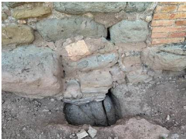
Imatges 240618-27 i 97. Exemples de cales de fonamentació a la cantonada sud-oest de la façana (C6), i a una cantonada de la sala central nord d'accés a l'edifici (C11), on trobem el recolzament del mur a l'estrat rocós a uns 24 i 10cm respectivament.
