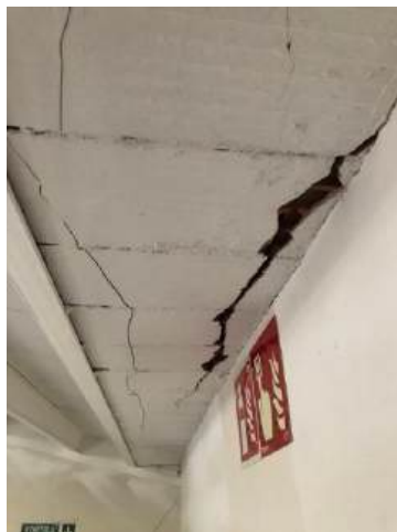
230626-61 i 230626-86. Esquerda a envà de planta primera per deformació de sostre inferior, i esquerda a sostre sotacoberta arran de façana nord.
