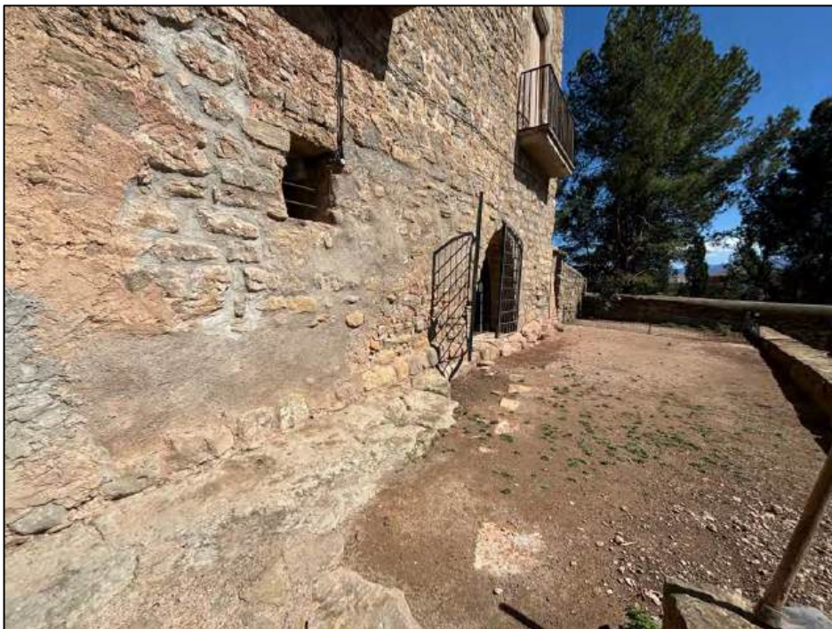
Figura 23. Aspecte del tram sud del mur UE 23, construït sobre el subsol natural de gres
