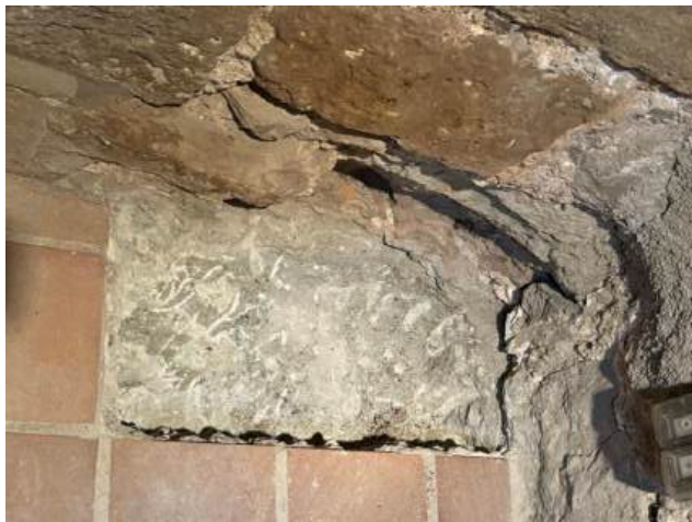
Imatges 240618-27 i 97. Exemples de cales de fonamentació a la cantonada sud-oest de la façana (C6), i a una cantonada de la sala central nord d'accés a l'edifici (C11), on trobem el recolzament del mur a l'estrat rocós a uns 24 i 10cm respectivament.
