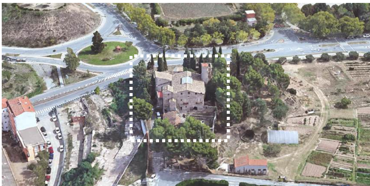
Imatge 01. Vista aèria de l'emplaçament de la Casa de la Culla, amb la carretera del Pont de Vilomara al fons. Font: Web Google-earth.
