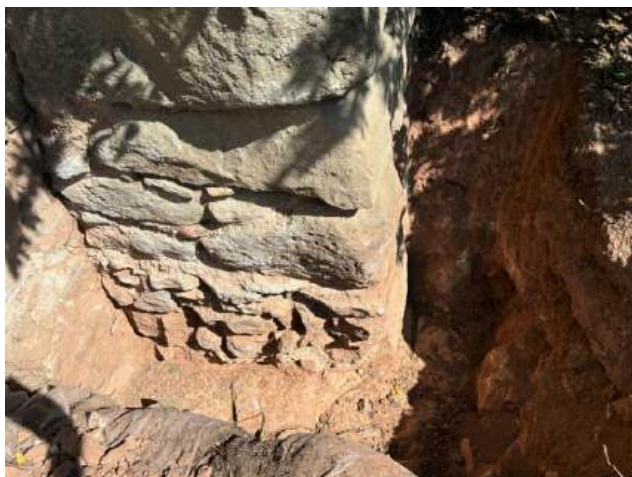
Imatges 240617-03 i 07. Exemples de cales de fonamentació a la cantonada sud-est de la torre (C8), i a l'extrem sud del contrafort de la façana est (C9), respectivament. En ambdós casos el recolzament del fonament en un estrat rocós es produeix a vora uns 100 cm de fondària.
