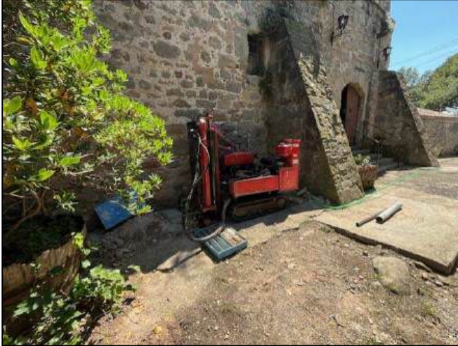
Foto 1. Treballs de realització del sondeig S1
