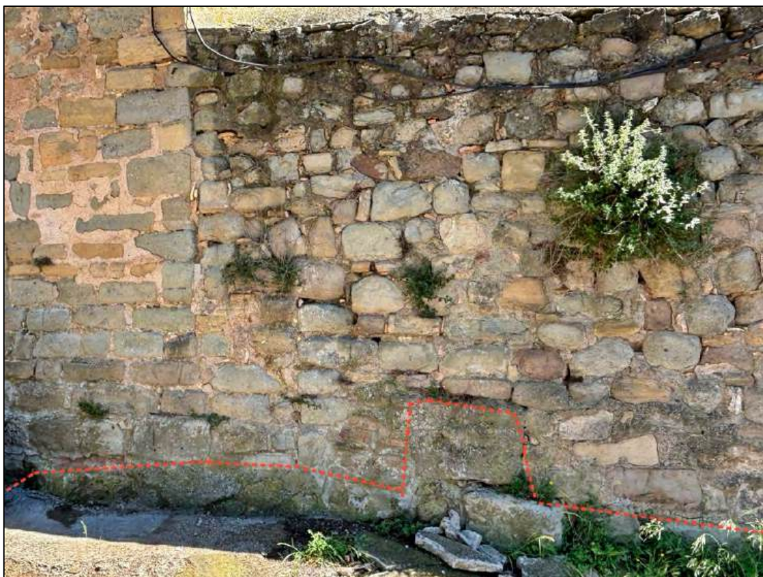
Figura 15. El mur UE 15 es fonamenta directament sobre l'estrat de gresos (marcat amb una línia vermella)
