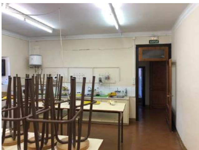
230626-61 i 230626-86. Esquerda a envà de planta primera per deformació de sostre inferior, i esquerda a sostre sotacoberta arran de façana nord.
