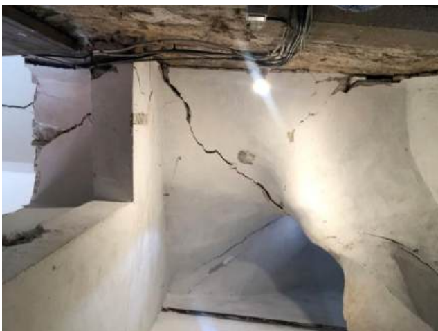
230920-191 i 230920-201. Esquerdas a les escales de cargol de la torre sud-est.
