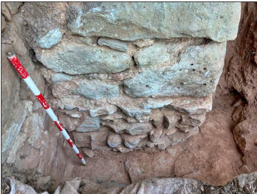
Figura 36. CALA 8. Aspecte de la banqueteta de fonamentació de la reparació UE 36
