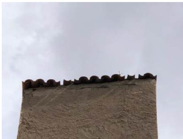
22011224 i 220729003. Exemples de trams de ràfecs amb desplaçaments i trencaments de teules ceràmiques àrabs, al volums annexos oest i de la caixa d'escala de la torre sud-est.
