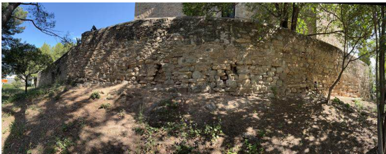
240618-54. Vista del desenvolupament del mur de contenció i tanca sud, vora la façana de l'edifici, amb descalçaments parcials.
