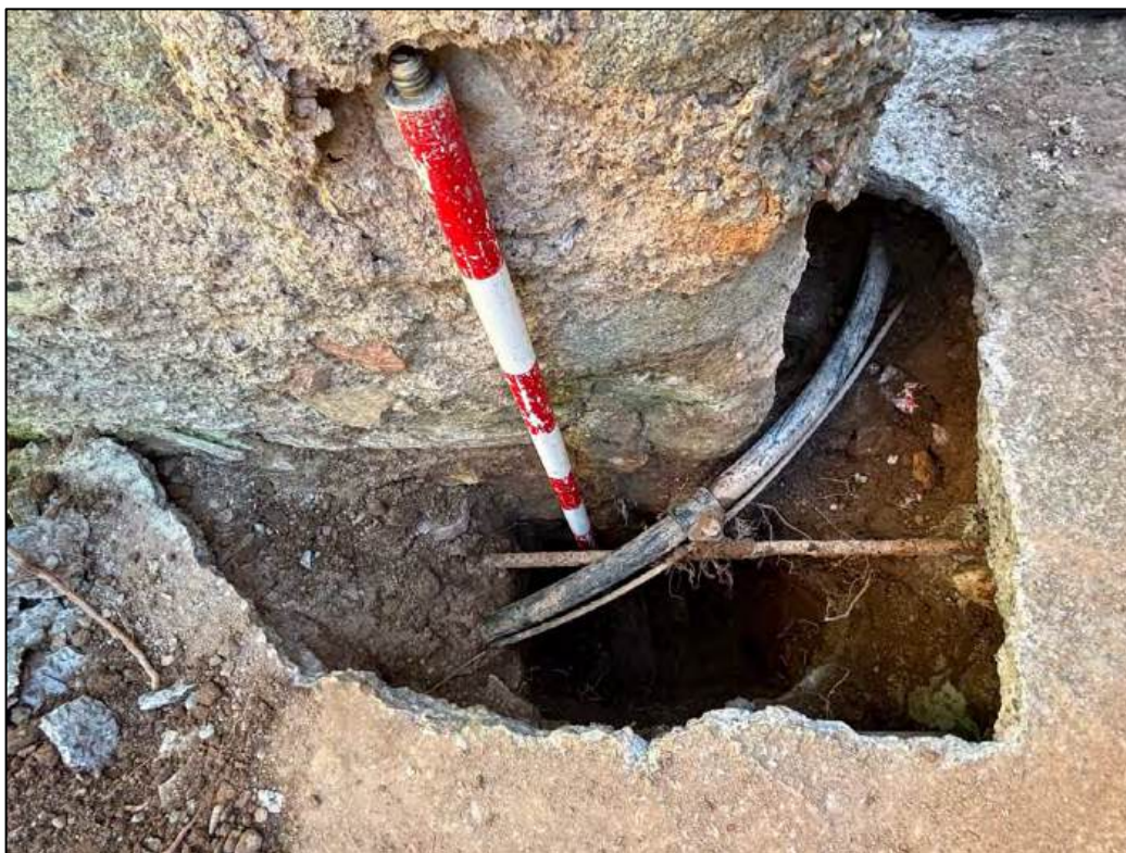
Figura 17. CALA 4. Aspecte de la cala, travessada per una instal·lació d'aigua
