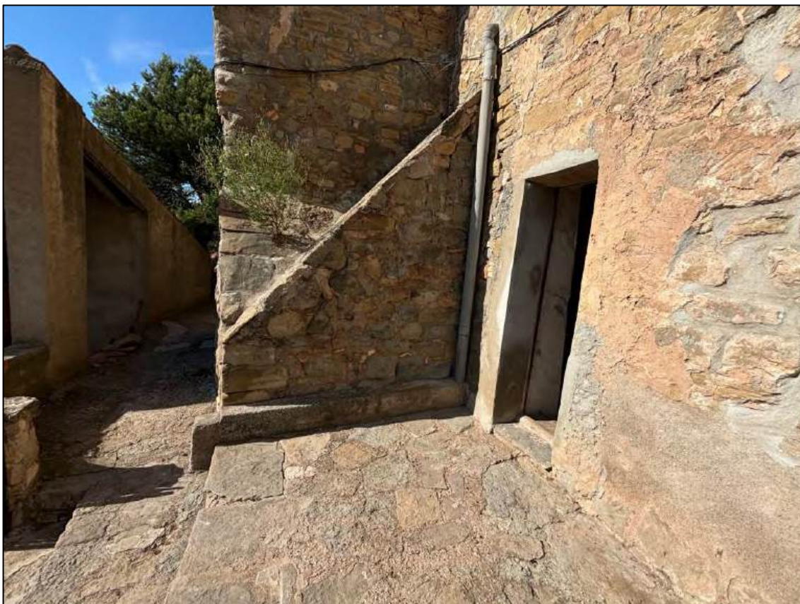
Figura 20. CALA 5. Situació entre el mur UE 23 i el contrafort
