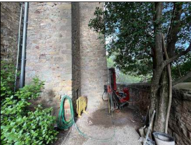
Foto 3. Treballs de realització del sondeig S3
