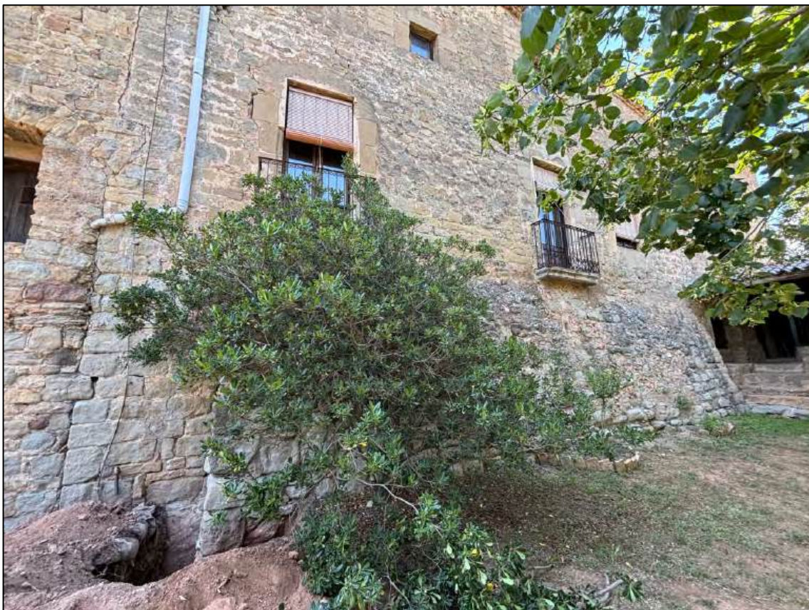
Figura 34. CALA 9. Situació entre el mur UE 35 i la reparació atalussada
