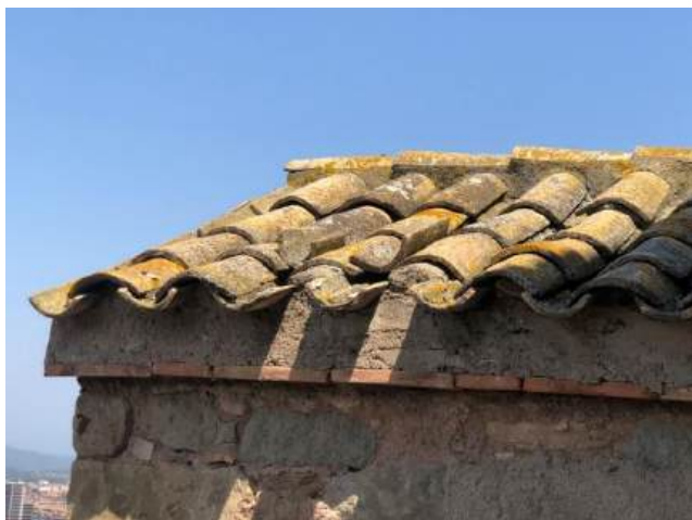
22011224 i 220729003. Exemples de trams de ràfecs amb desplaçaments i trencaments de teules ceràmiques àrabs, al volums annexos oest i de la caixa d'escala de la torre sud-est.
