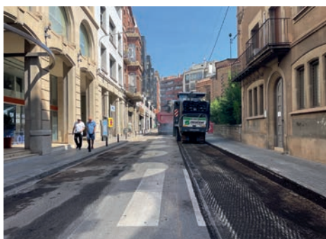
Els treballs d'asfaltatges dels carrers Gaudí i Carrió
