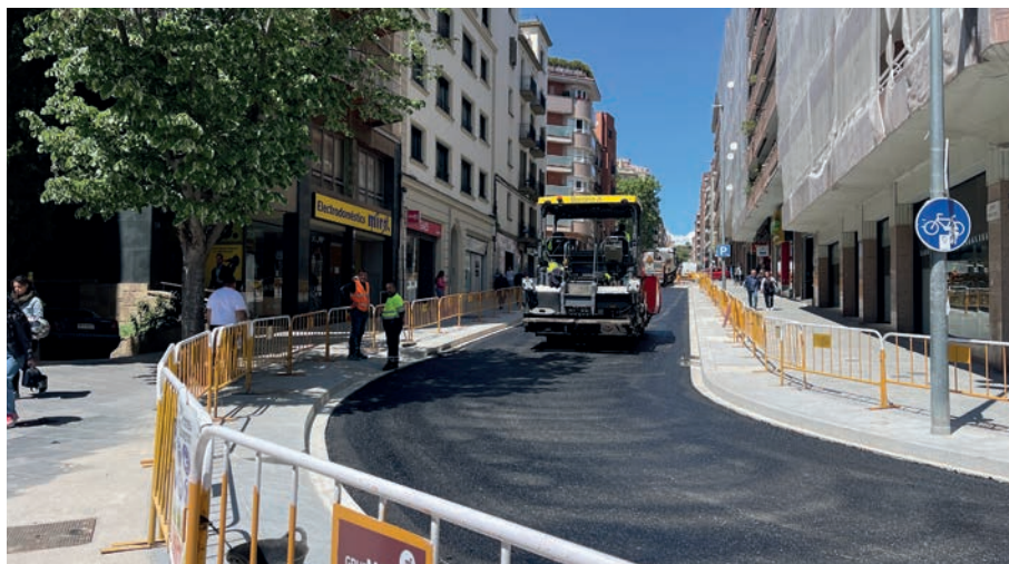
Les obres de la fase 1 s'han fet entre la plaça Neus Català Pallejà i el carrer Carrió
