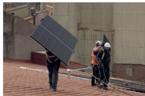
Les plaques s'han instal·lat durant els mesos de març
