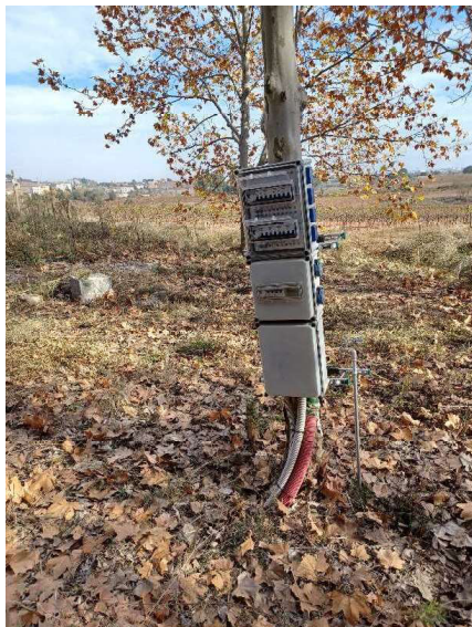
FOTOS 5 i 6 Torres de distribució elèctrica ancorades en arbres, i prestatge en safareig/aigüera, bàsic i del tot ineficient. Al voltant, les diferents unitats d'acampada
