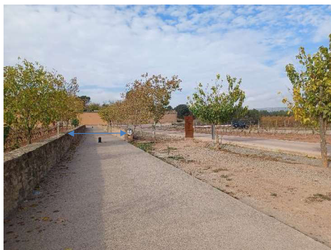
FOTO 2 Entrada principal del càmping, amb pas vianants obert al públic, i barrera d'obertura automàtica des de Recepció
