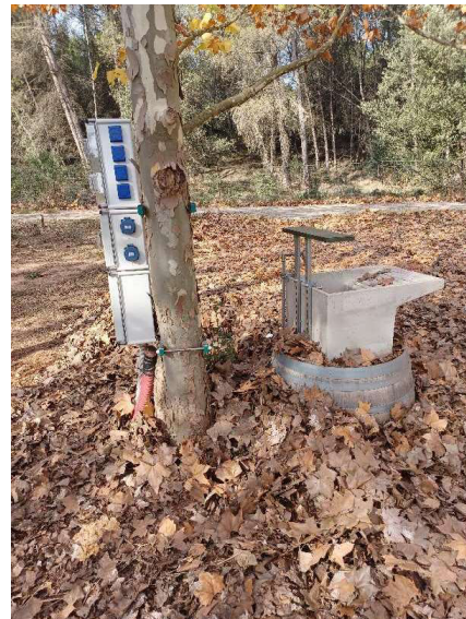
FOTOS 5 i 6 Torres de distribució elèctrica ancorades en arbres, i prestatge en safareig/aigüera, bàsic i del tot ineficient. Al voltant, les diferents unitats d'acampada
