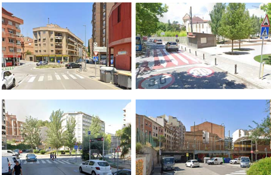
Passos de vianants i pendent on es troben el carrer d'Aragó amb el carrer de Camps i Fabrés Font: Google earth
