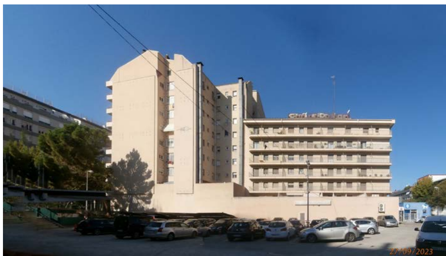
Vista des de l'interior de l'aparcament en superfície
