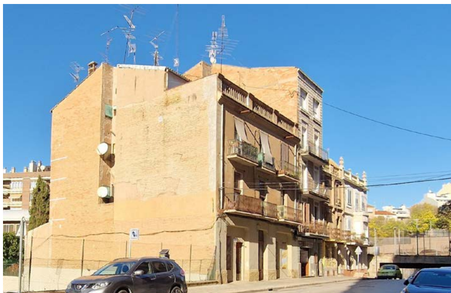
Vista de les edificacions residencials del carrer de Camps i Fabrès
