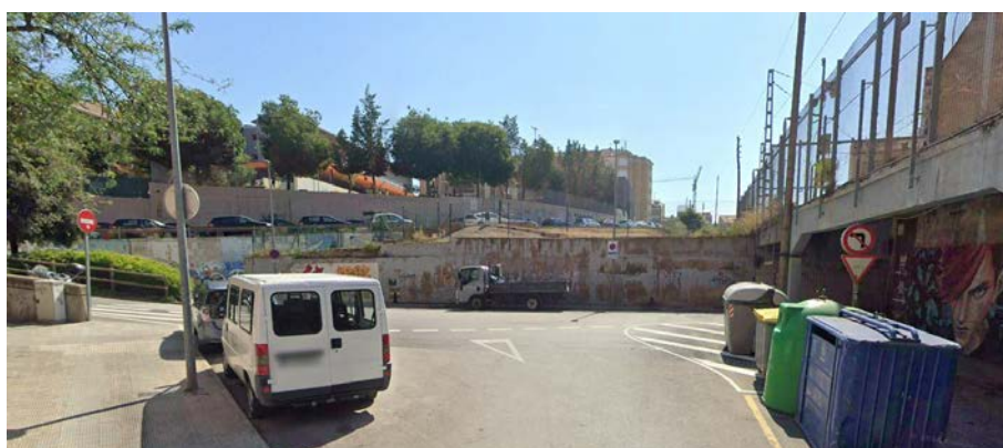
Imatge del final del carrer d'Aragó, que acaba amb un mur de contenció de 5 metres d'alçada sense continuïtat amb el carrer de la Cerdanya, situat a la cota més elevada. Font: Google Maps
