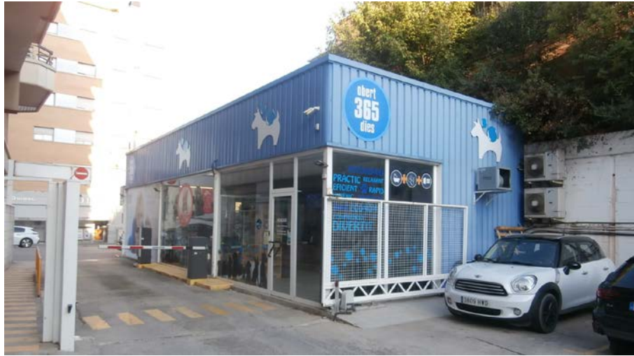
Vista des de l'interior de l'aparcament de la construcció situada en paral·lel a l'accés de l'aparcament
