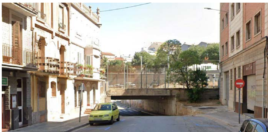
Imatge del pas inferior des del carrer de Camps i Fabrés. Font: Google Maps
