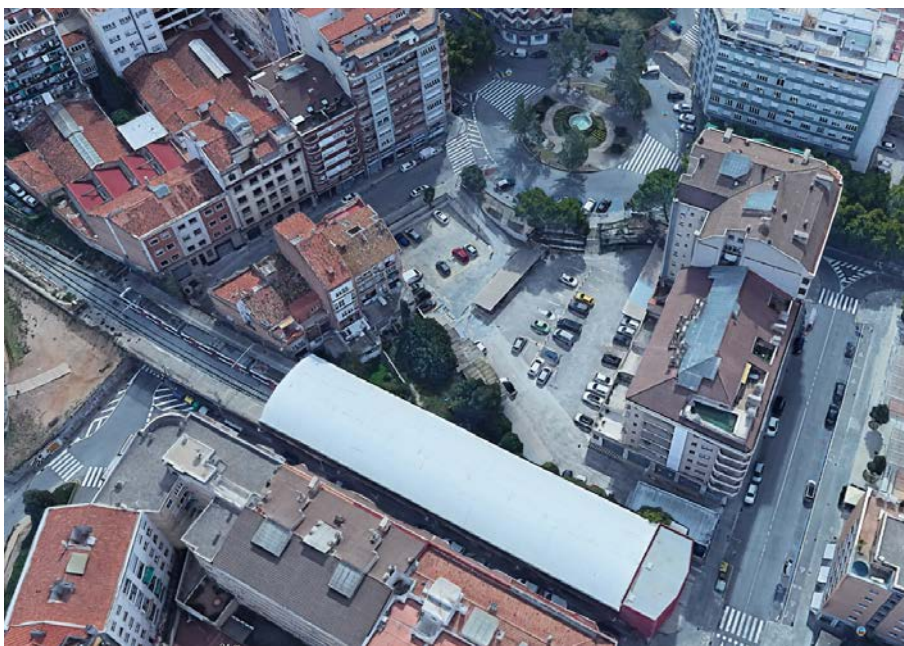
Vista aèria des del nord de l'àmbit. Entre la plaça de l'Onze de Setembre i l'estació del Baixador de Manresa es situa un gran buit urbà enfonsat respecte la via pública. Font: Google Maps
