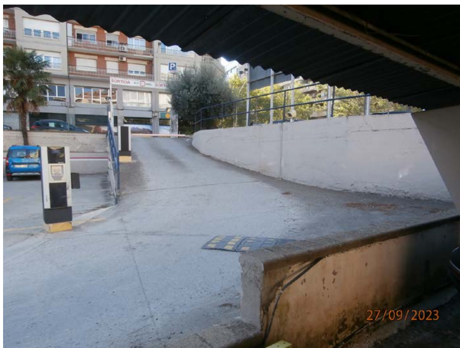
Vista de la rampa de sortida cap al carrer de Camps i Fabrès des de l'interior de l'aparcament
