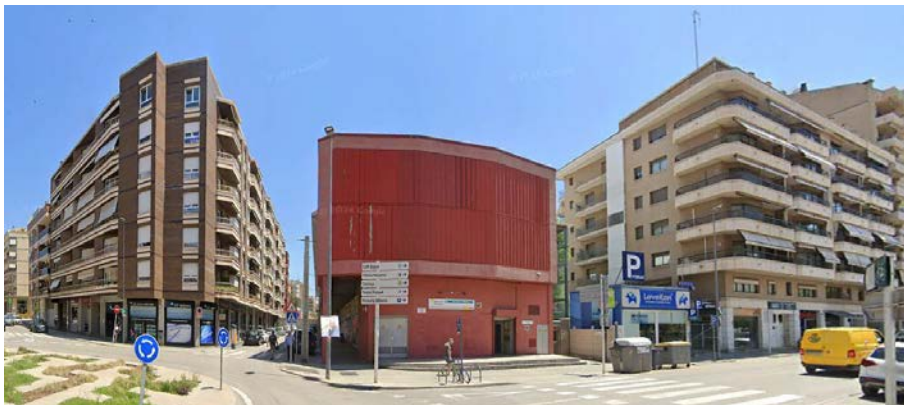
Composició a partir d'imatges de Google Maps. Vista de l'estació Manresa Baixador des del carrer del Primer de Maig
