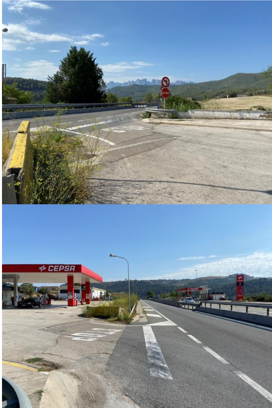
Il·lustració 2. Entrada C-55 des de gasolinera i Nau agrícola sentit Barcelona.
