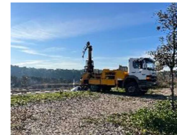
Fot. 1. Zona de treball a la plataforma superior on està situada la rotonda existent
