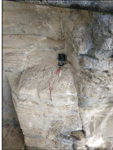
Foto 2. Mesura de discontinuïtats en el sòcol.
