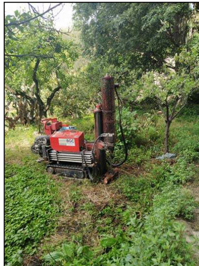
Foto 5. Treballs de realització del sondeig P1.
