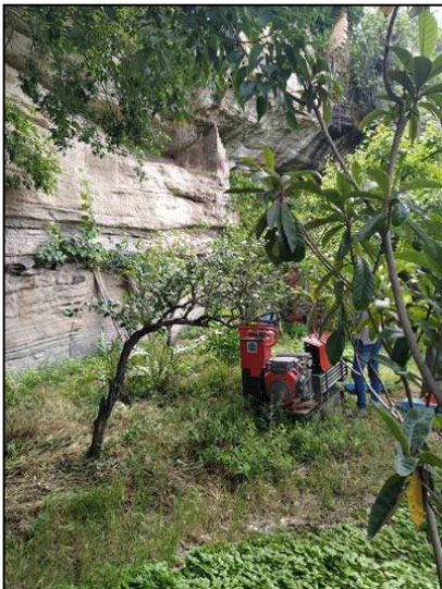
Foto 4. Treballs de realització del sondeig S1
