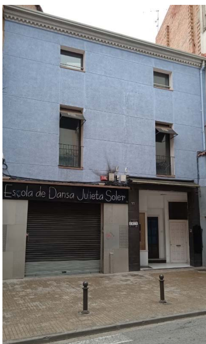
Façana de l'immoble del c/. Cos, 11
