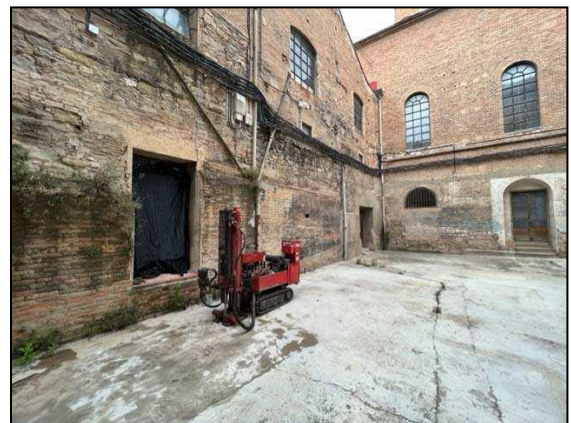
Foto 4. Treballs de realització del sondeig P4
