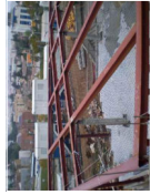
EXEMPLE DE MUNTATGE DE XARXA REUTILITZABLE AMB GANXO
