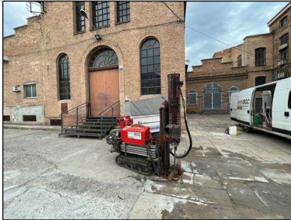
Foto 1. Treballs de realització del sondeig P1
