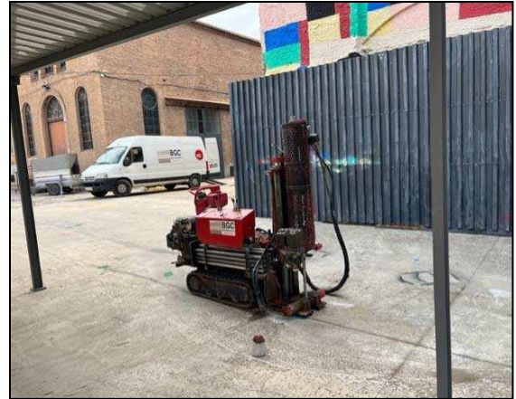
Foto 2. Treballs de realització del sondeig P2.
