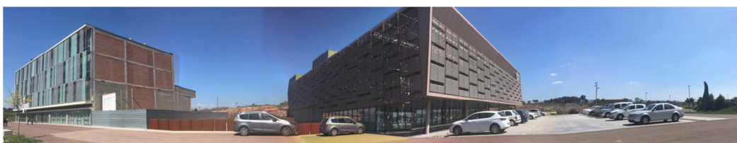
Foto 7. Imatge de les edificacions existents: el Centre Tecnològic del Bages i l'edifici Impuls
