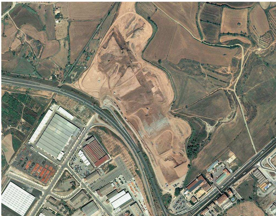
Imatge 13: Ortofotomapa de l'any 2008. Moment en que s'estaven realitzant els moviments de terres per la urbanització de l'àmbit.
